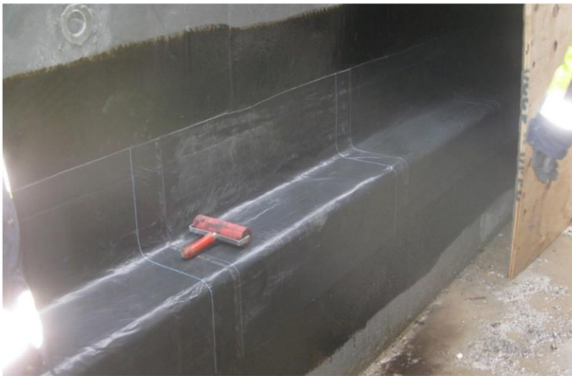
Figur 55. Tætning mellem kældervæg og betonbundplade udført med koldmonteret membran. (Fosroc Proofex 3000, fotograf Walter Sebastian NCC)
